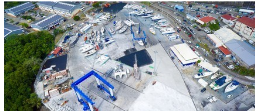
Figure 40 : Aire de carénage Marin (source Carenantilles)
