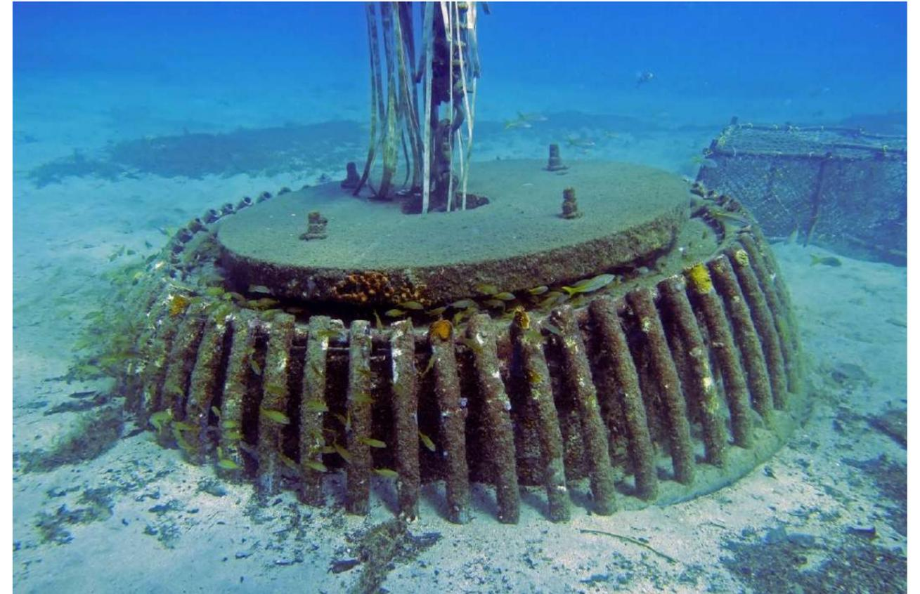
**Figure 10 : Module double plateau avec ceinture de tubes**
