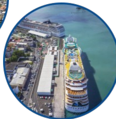
| Grand Port Maritime (Guadeloupe) © Guadeloupe Port Caraïbes
